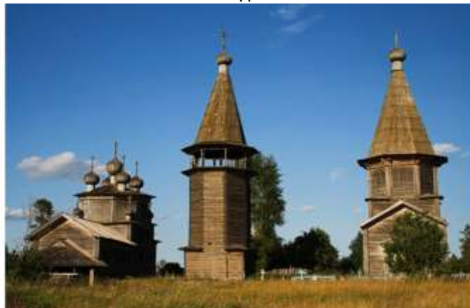
Колокольня в ансамбле Лядинского погоста
