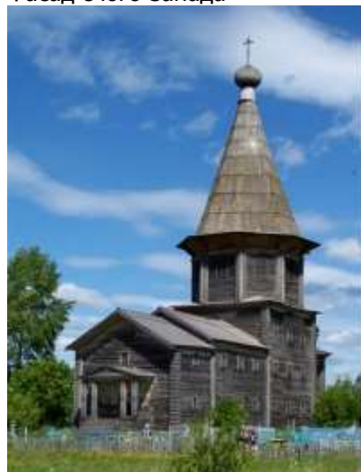
Фасад с юго-запада
