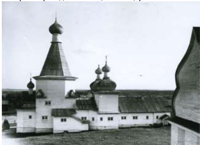
Северный фасад Благовещенской церкви
