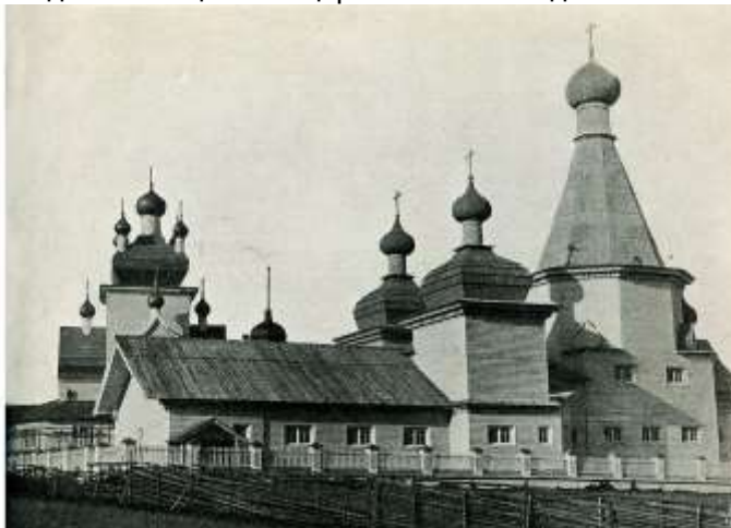
Вид Благовещенской церкви с юго-запада
