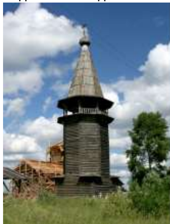
Вид с юго-запада
